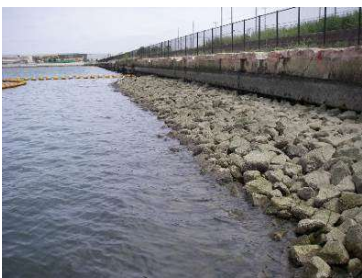
写真-4 捨石緩傾斜型護岸の様子
