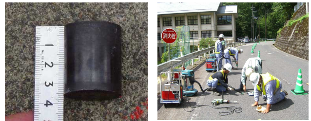
図-4 磁気マーカおよび埋設工事実施の状況
