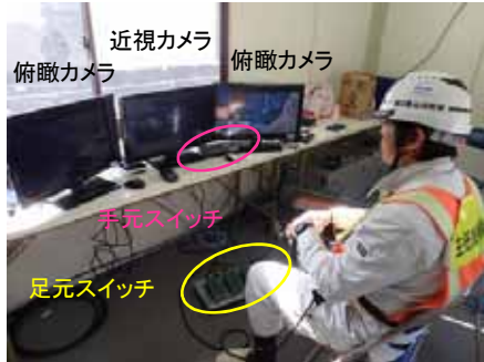
図-17 視野確保による操作状況
