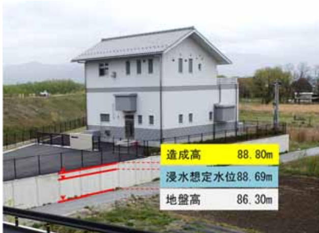
図-3 姉川中継ポンプ場の嵩上げ状況
