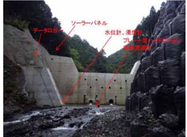
図-2 観測機器設置箇所の概要
