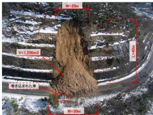
写真-1 被災全景
