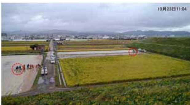
写真-2 被災箇所遠景 (堤防上より撮影) (R4,R5地点)
