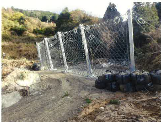
写真-6 強靱ワイヤーネット工設置状況 (梅本地区)
