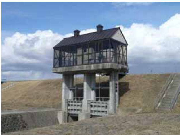
図-10 アルミ鋼構造の上屋施工例 (国交省 佐平治排水樋管)
