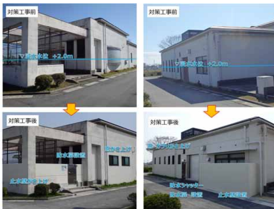
図-10 長浜中継ポンプ場における耐水対策工事実施状況
