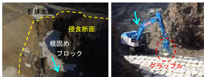
図-12 根固めブロックの設置状況
