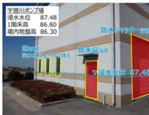
図-8 近江中継ポンプ場(上) 宇曾川中継ポンプ場(下)における対策の一部
