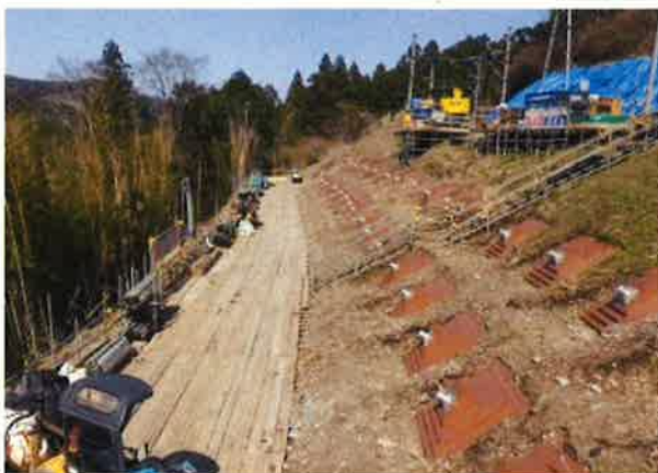
写真-7 アンカー工施工状況(上古沢地区)
