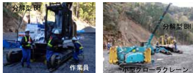
図-13 分解型 BH の組み立て状況
