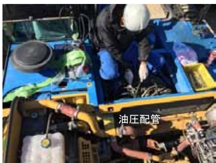
図-14 油圧配管つなぎ替え状況
