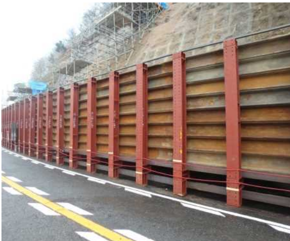
写真-2 仮設防護柵
