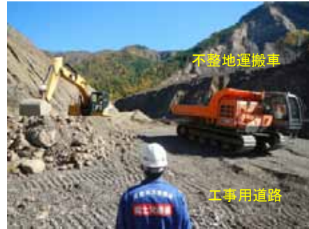
図-5 復旧対応状況
