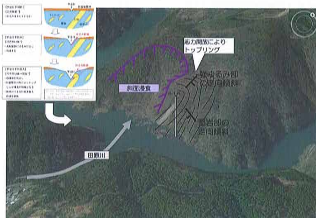
図-10 崩壊箇所周辺の重力変形全体像
