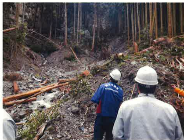
写真-8 土砂災害専門家による現地調査
