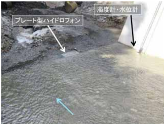
写真-1 台風21号による降雨 観測箇所周辺を上流側より撮影
