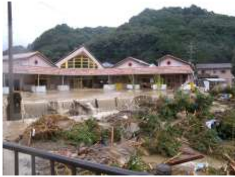
図-3 保育所（避難所）の被災状況
