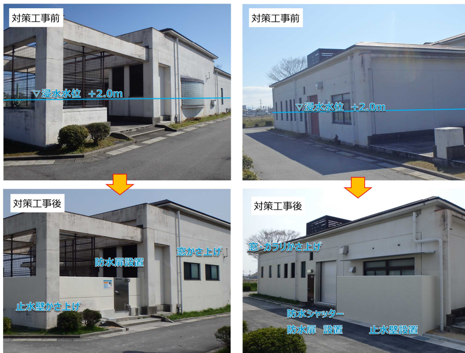
図-10 長浜中継ポンプ場における耐水対策工事実施状況
