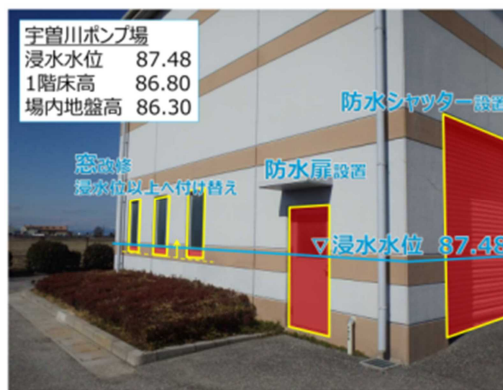
図-8 近江中継ポンプ場(上) 宇曾川中継ポンプ場(下)における対策の一部
