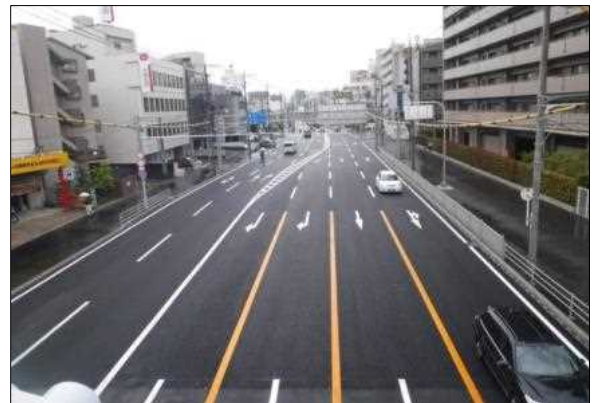
写真-3 国道171号京都向き(整備後)
