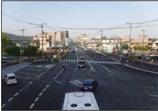
写真4 国道171号神戸向きの状況(整備後)
