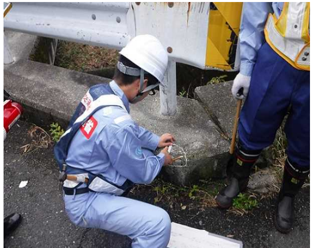
写真-01 点検状況
