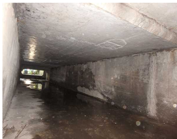
写真-04 広瀬1号橋
