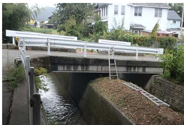
写真-03 今津川副道橋上り
