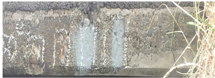
写真-08 防錆スプレー塗布
