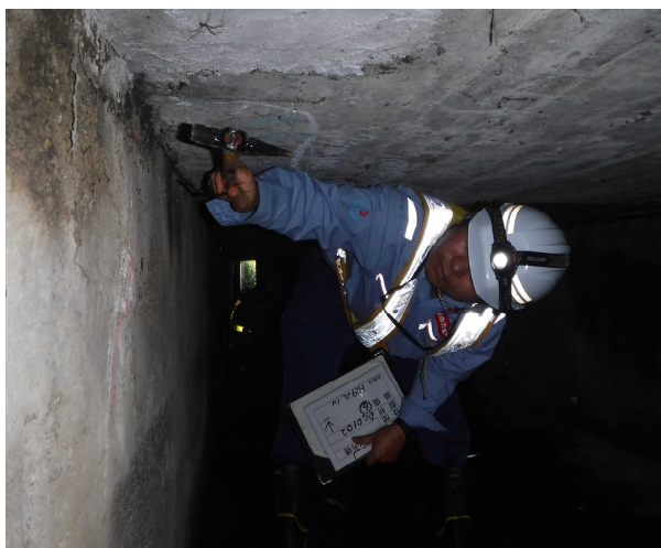
写真-06 広瀬1号橋 点検状況写真
