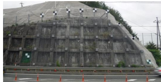
写真-7 MMS計測用のターゲット
