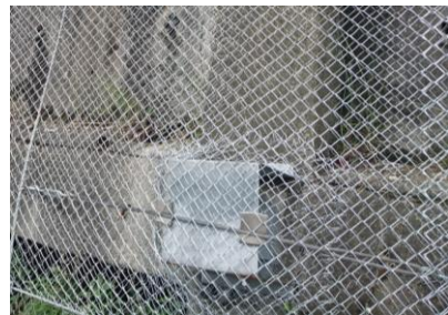
写真-5 リフトオフ試験後のアンカー頭部対策
