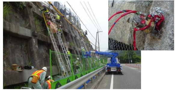
写真-4 リフトオフ試験実施状況
