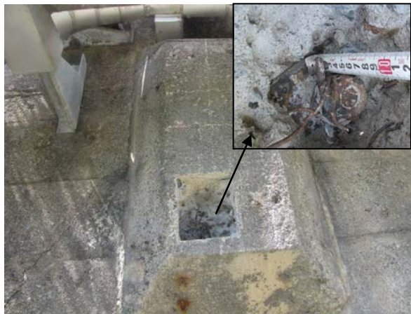
写真-4 はつり箇所
