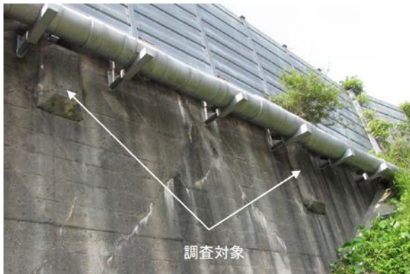
写真-3 既存定着部の調査対象
