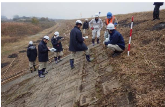
写真-2 合同点検状況
