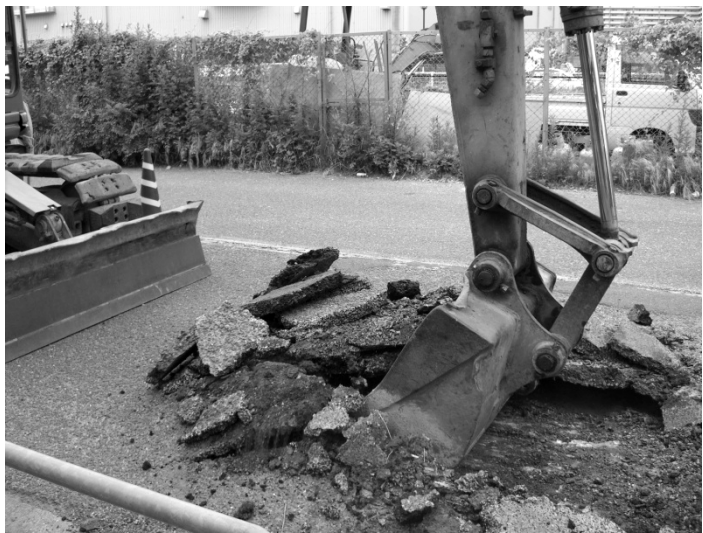
バックホウによるアスファルト混合物のはぎ取り
