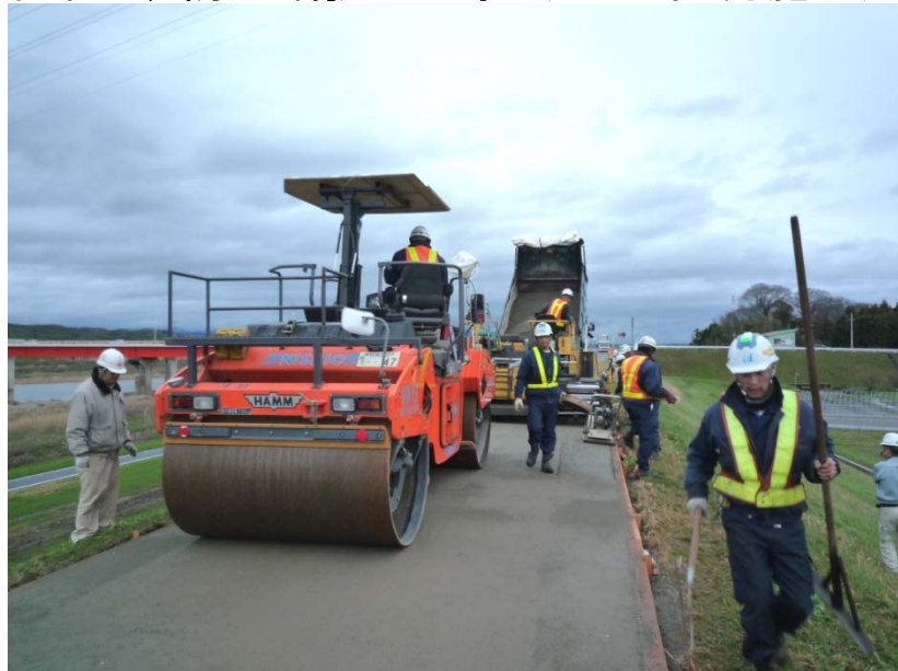
木津川堤防天端強化工事（2010年3月施工）
