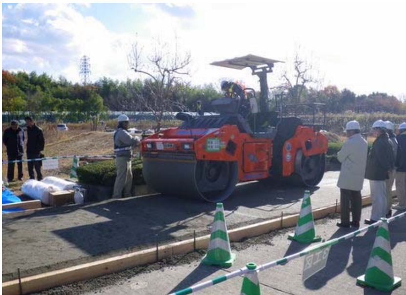
近畿地整近畿技術事務所構内（2009年12月施工）
