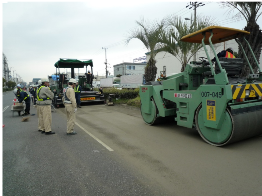
咲洲域内道路補修工事（2010年3月施工）
