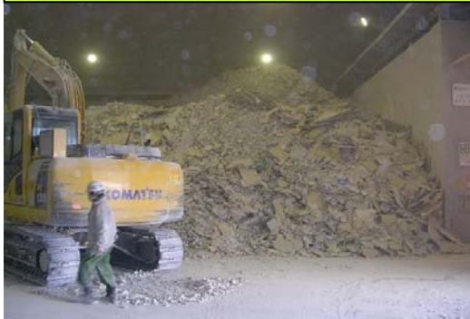
廃石膏ボードストックヤード
