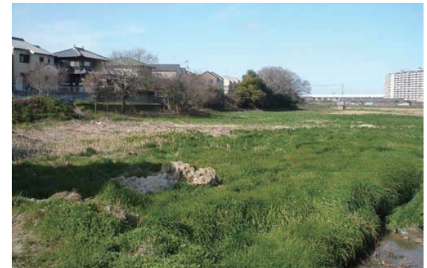
大阪府堺市牛飼池地盤改良工事
