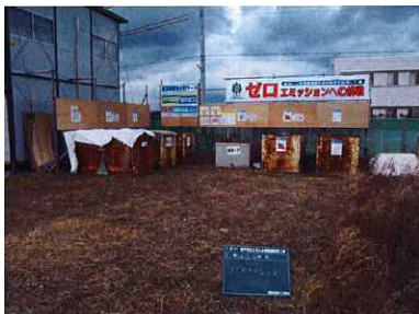
コンテナの設置状況
