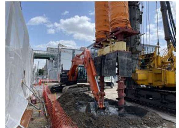
深層混合処理工法
