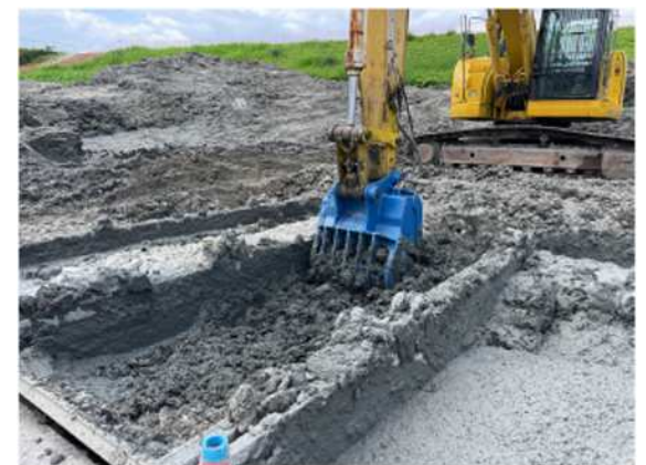
建設汚泥と固化材の混練り
