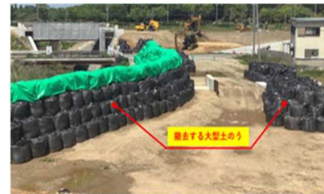
撤去予定の大型土のう袋
