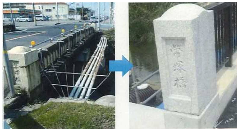
親柱(昭和6年の貴重な土木構造物)の再利用
