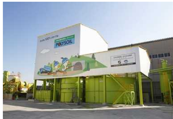
流動化処理土 製造プラント
