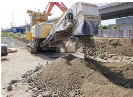
移動式改良機による改良土の状況
