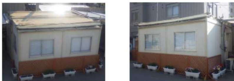
休憩所の屋根スペース発泡スチロール設置状況
