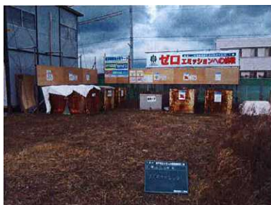
コンテナの設置状況
