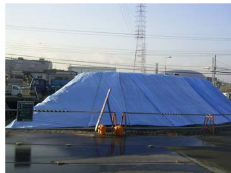
セメント混じり排泥土仮置き
