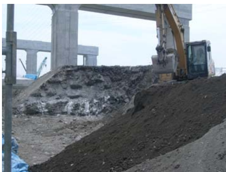
廃棄物混じり土の分級分別作業
