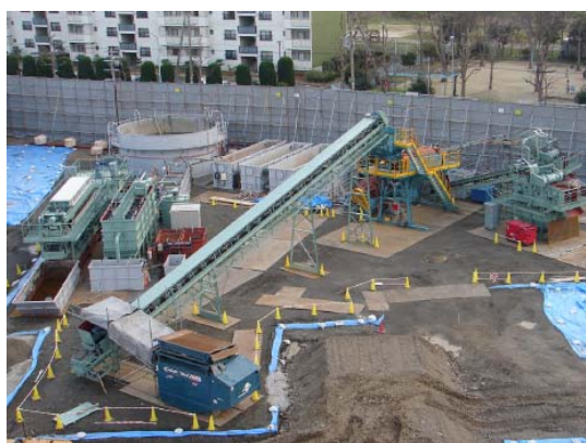
プラント設置状況
