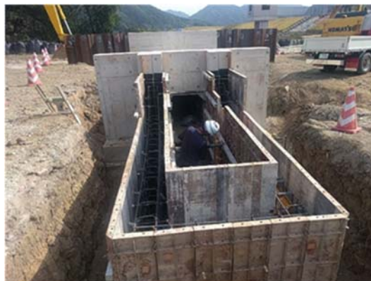
鋼製型枠工事近景
