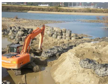
袋詰玉石の設置状況
