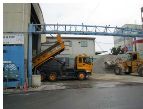
再生碎石プラント
