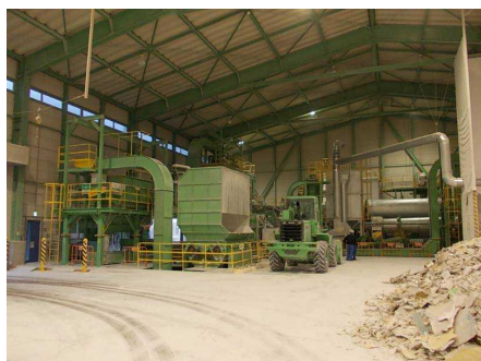
プラントの様子
