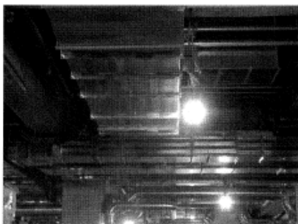
給排気ダクトの原寸取り工場加工
