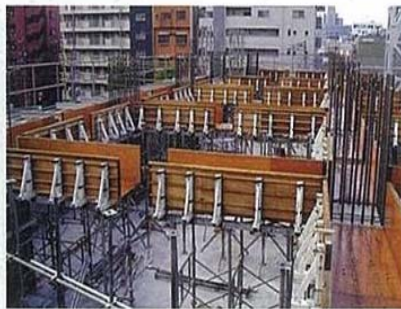
梁システム型枠採用
