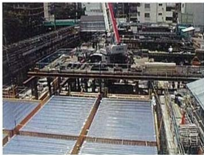
床版のデッキプレート
