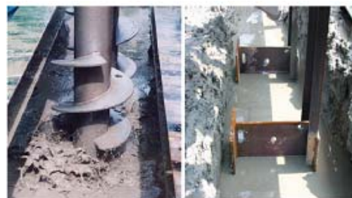
高流動化技術の施工状況
