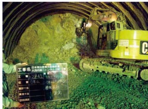
大型ブレイカーによる追加掘削
