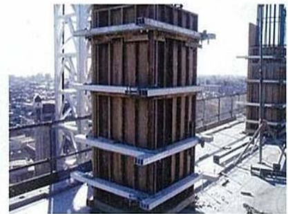
柱システム型枠採用
