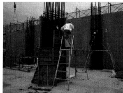
柱型枠に特注寸法パネルを使用
