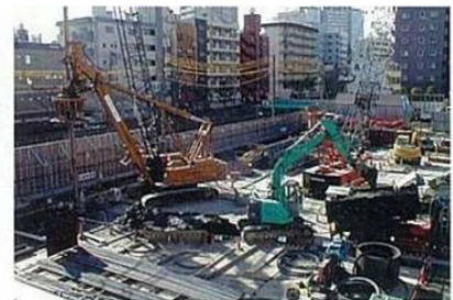
杭埋戻しに掘削土を使用
