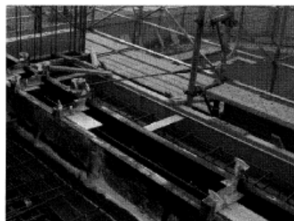
床立上り躯体に鋼製型枠を使用
