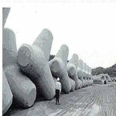
リサイクルコンクリートを用いた80t消波ブロック
