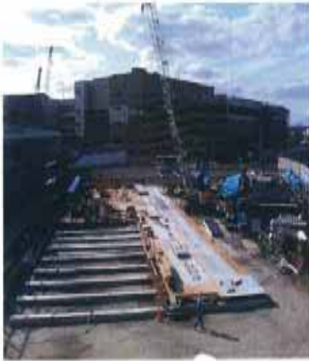
作業所内にサイトPCヤードを 設置してPCを製作
