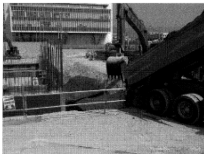
杭汚泥の「自ら利用」
