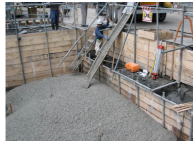
実施における打設状況
