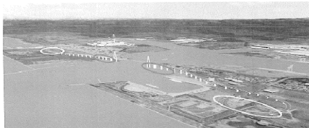
土工部の盛土材や海上橋脚埋立の埋立材として利用
