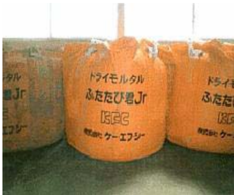
モルタル納入状況
