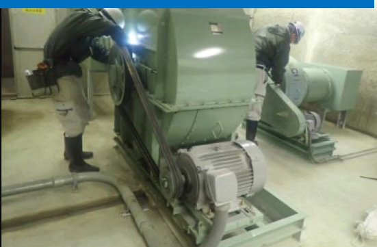
換気ファンベルト劣化点検
