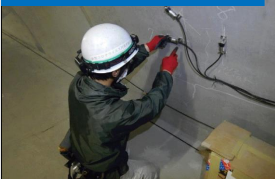
共同溝躯体のひび割れ調査
