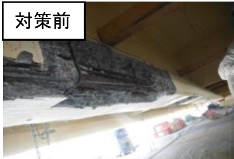
主桁鉄筋の腐食
