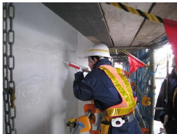
橋梁補修体験
