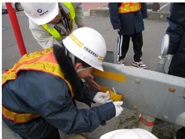
ガードレールの反射シール貼り
