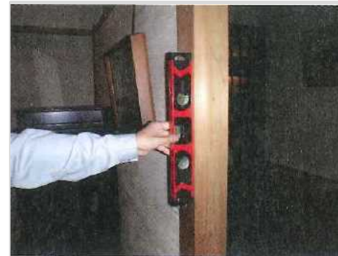
水平器による柱の傾きの計測
