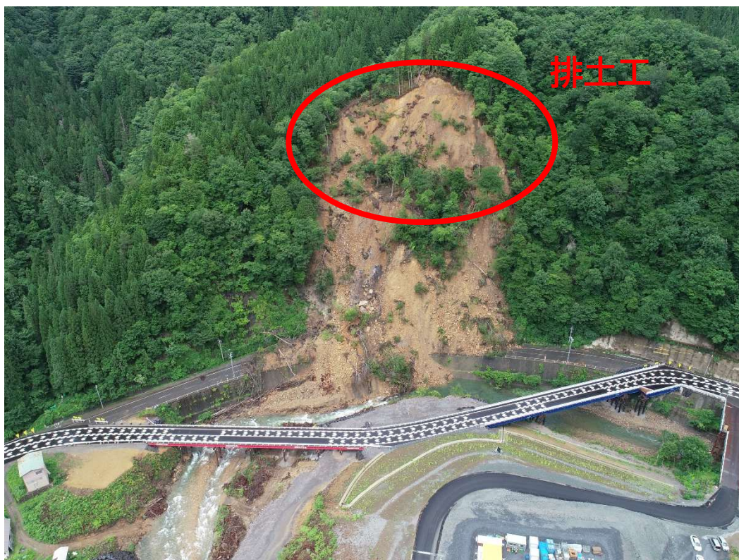
写真 1. 応急的な措置（排土工）
