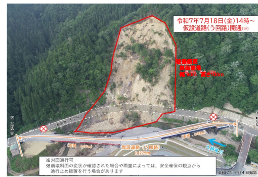
【写真③】仮設道路(迂回路)の状況
