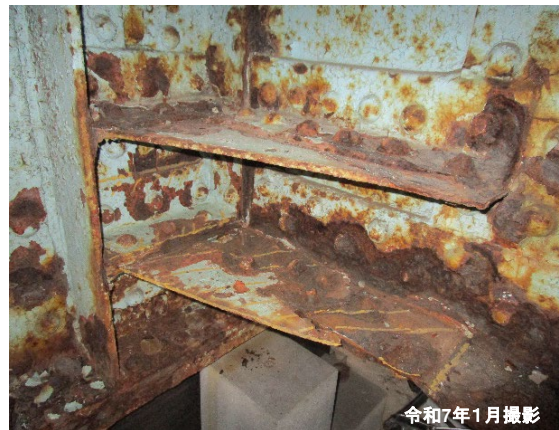
縦桁(ボルト)の損傷
