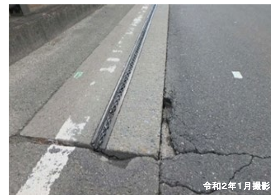
縦目地部の損傷
