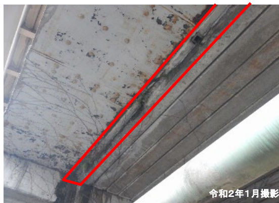
縦目地部の遊離石灰(漏水)
