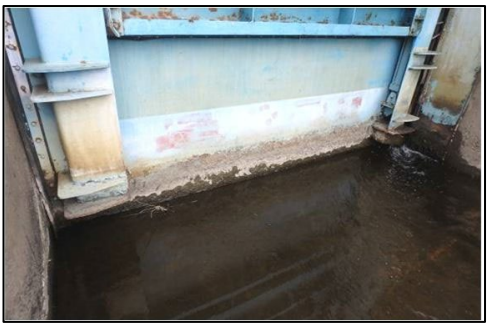
損傷箇所(ゲートの腐食)
