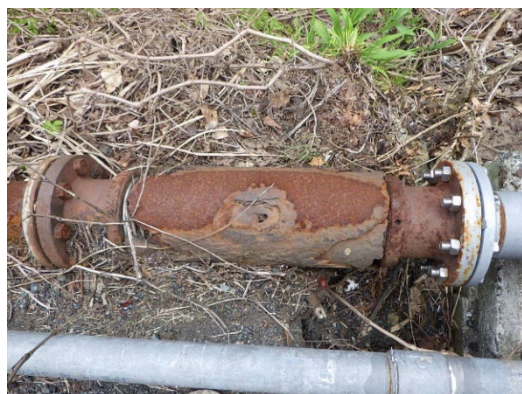
配管腐食状況
