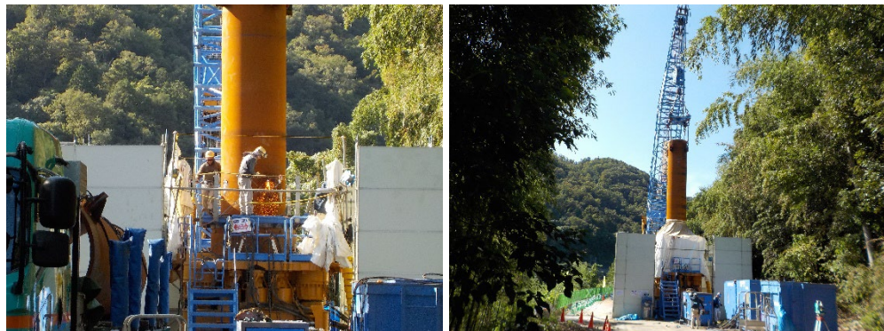
鋼管杭施工状況
