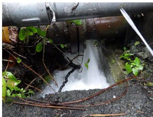
送水管の漏水の状況
