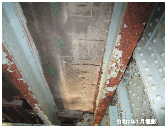
主桁・床版の腐食
