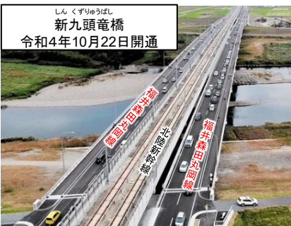
道路と新幹線が下部工を共有する併用橋
