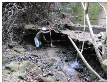
水叩損傷状況
