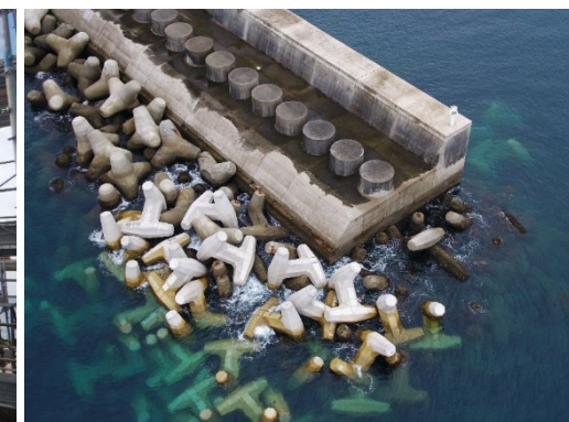
【消波ブロック設置(復旧)状況】
