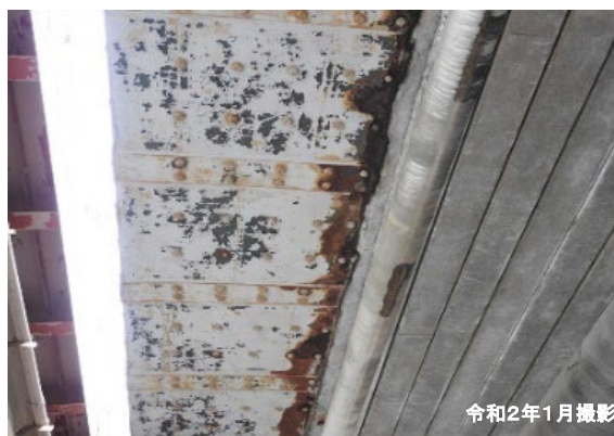
補強鋼板の腐食
