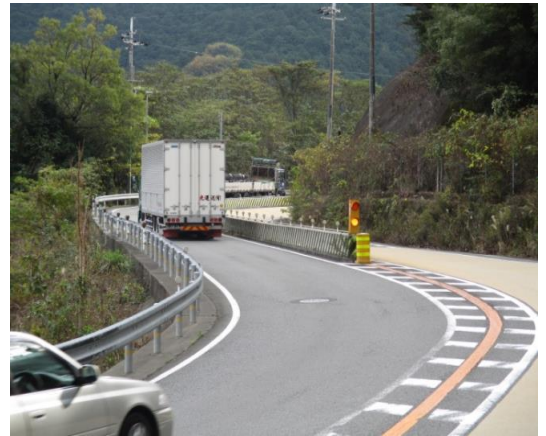
写真② 国道42号 【線形不良箇所】
