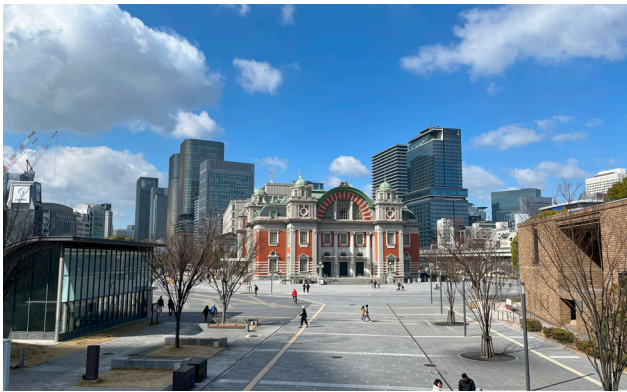
公会堂前広場は中之島景観軸の軸線と公会堂の向きとのずれに違和感がなく、おおらかにシンプルな円弧の形状とした。景観軸や見通しの形成の観点、文化・芸術の交流の場づくりの観点から、道路施設については可能な限り削減し、公会堂を際立たせている。
