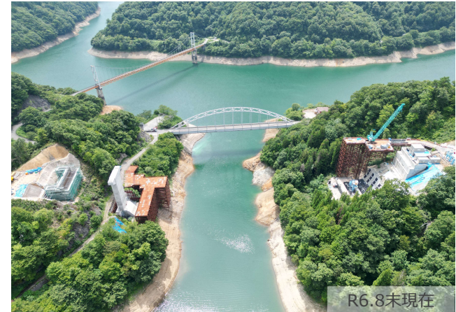
新子馬巢谷橋の状況
