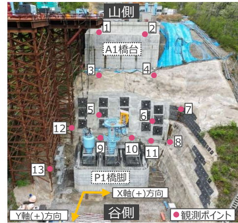
■ 写真1 隣接切土法面の観測ポイント
