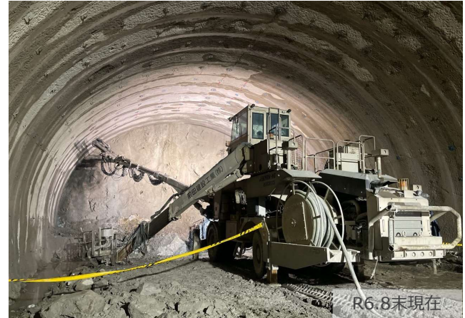
大谷トンネルの掘削状況
