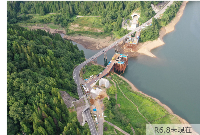
新林谷橋の状況
