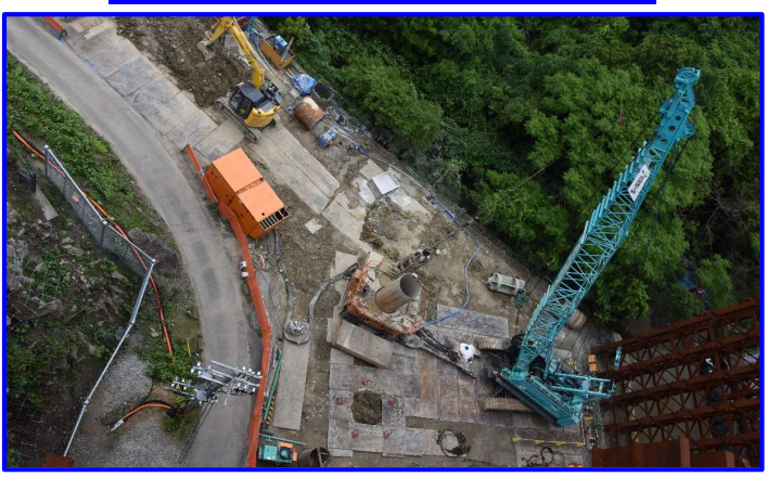
硬質岩によりビットが損耗し掘削難航
