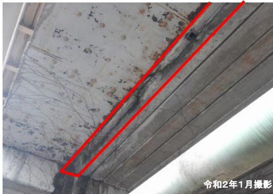
縦目地部の遊離石灰(漏水)
