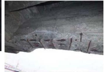
【脚柱部、上部工はり部のコンクリート剥離、鉄筋腐食】
