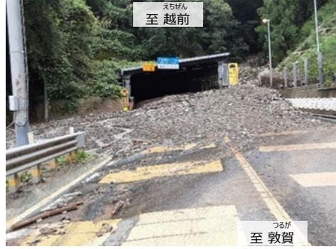
写真1 令和4年8月豪雨時の土砂流出状況
