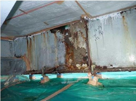
主桁の腐食
