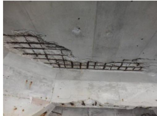
【上部工のコンクリート剥離、鉄筋腐食】
