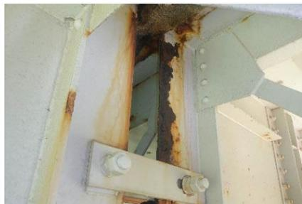
主桁の腐食
