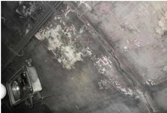
既設剥落防止材の劣化
