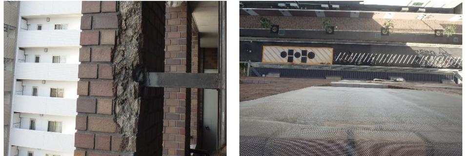
築後52年、大修繕実施から27年が経過し、外壁タイルの浮き・欠損等の不具合が多数発生している。タイル剥落防止ネットで防いでいる状況。
