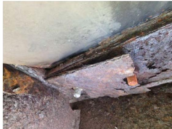
鋼床板 (補強部材) の腐食・層状剥離
