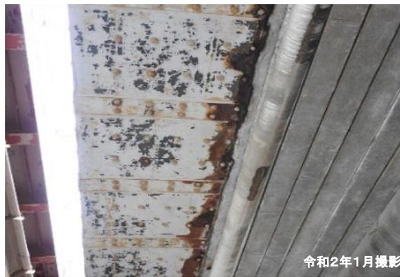
補強鋼板の腐食
