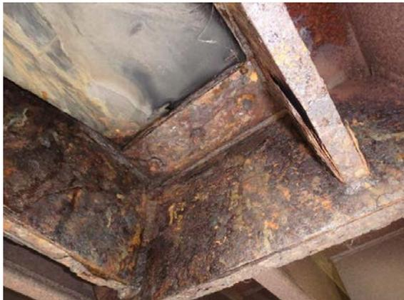
鋼床板 (補強部材) の腐食
