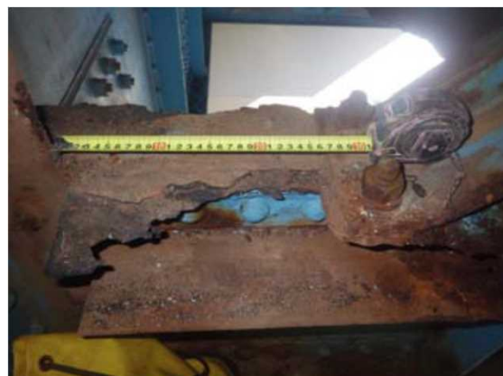
横桁の腐食
