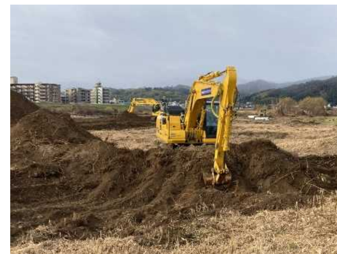
桂上野地区 河道掘削状況
