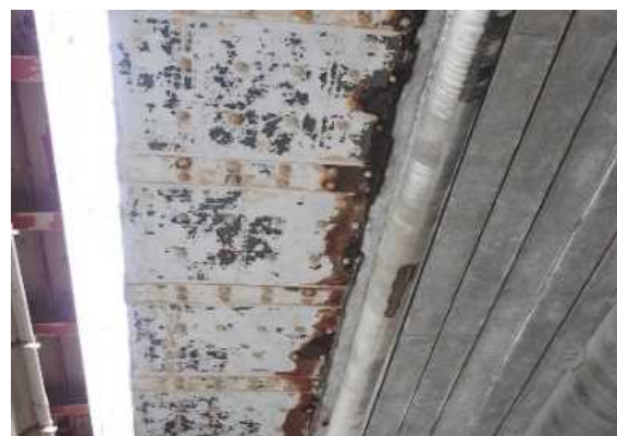
補強鋼板の腐食
