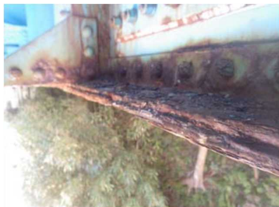
主桁の腐食
