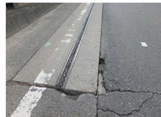
縦目地部の損傷
