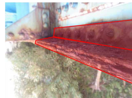
対策イメージ(あて板補修+塗装)
