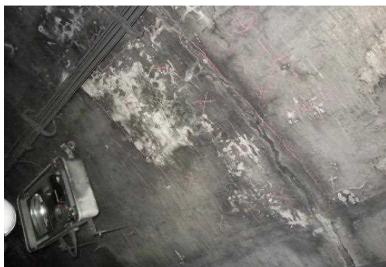
既設剥落防止の劣化
