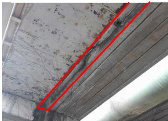
縦目地部の遊離石灰(漏水)
