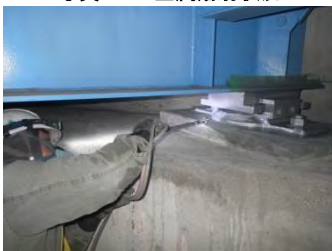
写真-5 上塗塗装施工状況
