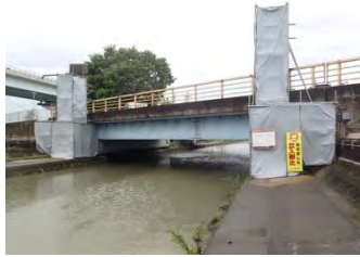
写真-2 飛散養生
