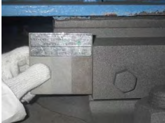
写真-3 素地調整完了
