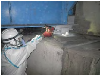
写真-4 金属溶射状況
