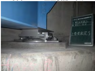
写真-6 上塗塗装完了
