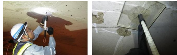
写真-7 施工状況 (QS-170029-A)
