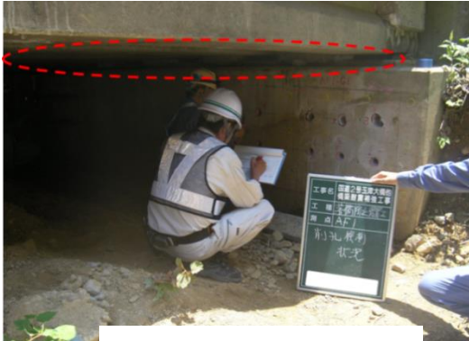
写真-3 現地状況
