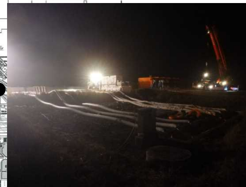
▲第1排水区排水作業中(9/6 0:21)
