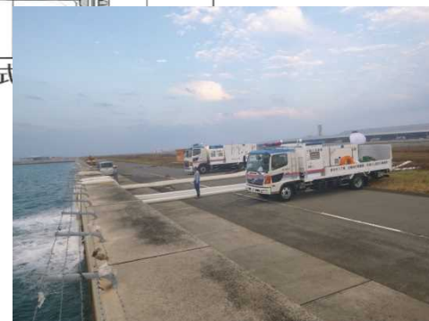
▲第1排水区排水作業中(9/6 5:52)
