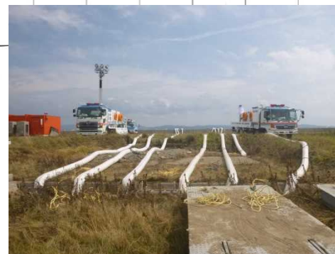
▲第3排水区排水作業中(9/6 13:39)
