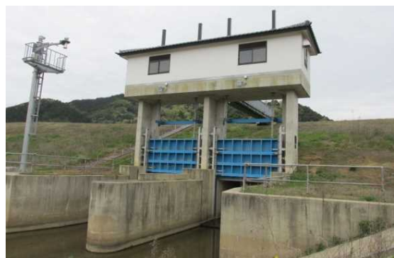
志高中央樋門(河川側から)
