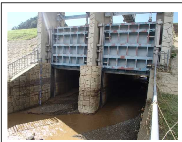
土砂堆積時の様子(蓼原川樋門)
