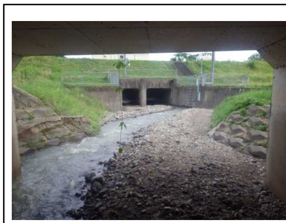
土砂堆積時の様子(東谷川樋門)
