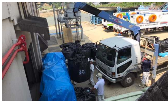
土のうによる浸水対策
