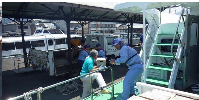
支援物資荷卸し状況
