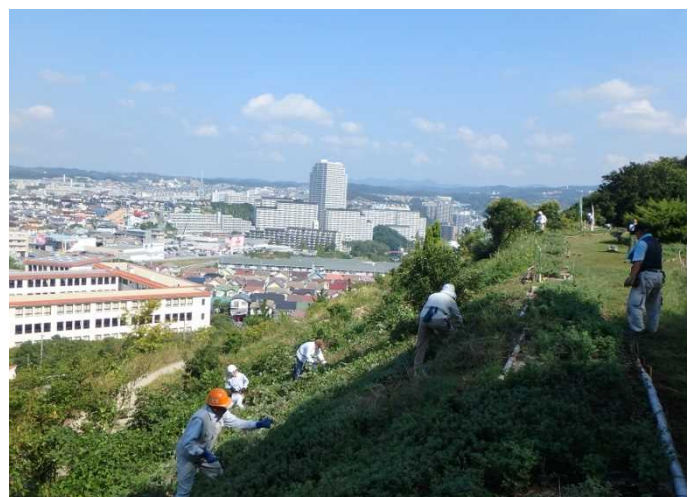
除草作業の様子
