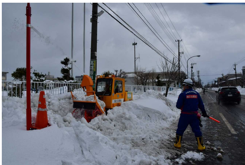
除雪作業状況（福井市）
