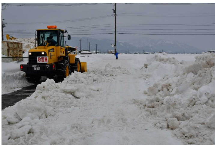
除雪作業状況（坂井市）
