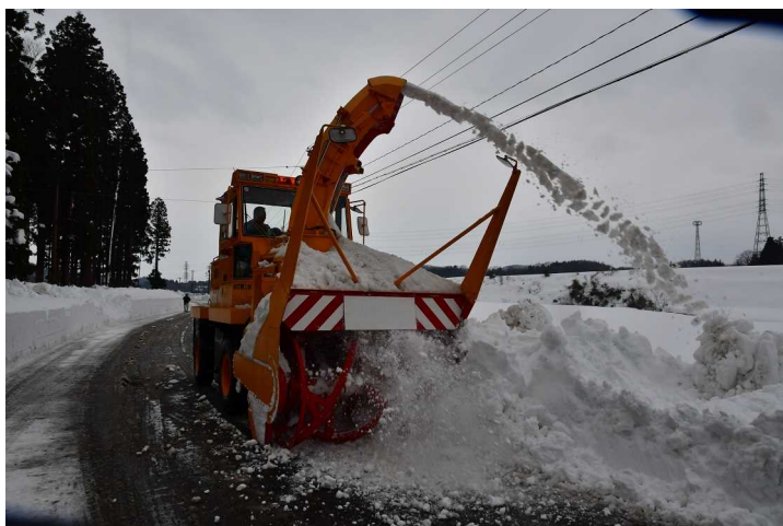
除雪作業状況（あわら市）
