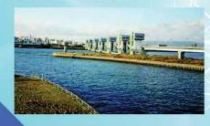
淀川大堰は淀川の下流で水をせき止めて水道などの水を取れるようにしています。
