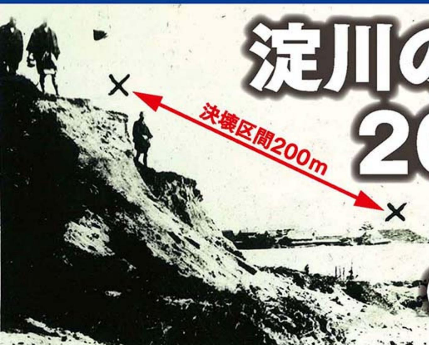
大正6年(1917年)10月1日、台風による連日の大雨で淀川の水位が上昇し、大冠村(現在の高槻市大塚地先)の堤防が200mにわたって決壊しました。氾濫した水は、西成郡(現在の大阪市西淀川区)まで到達し、甚大な被害をもたらしました。
