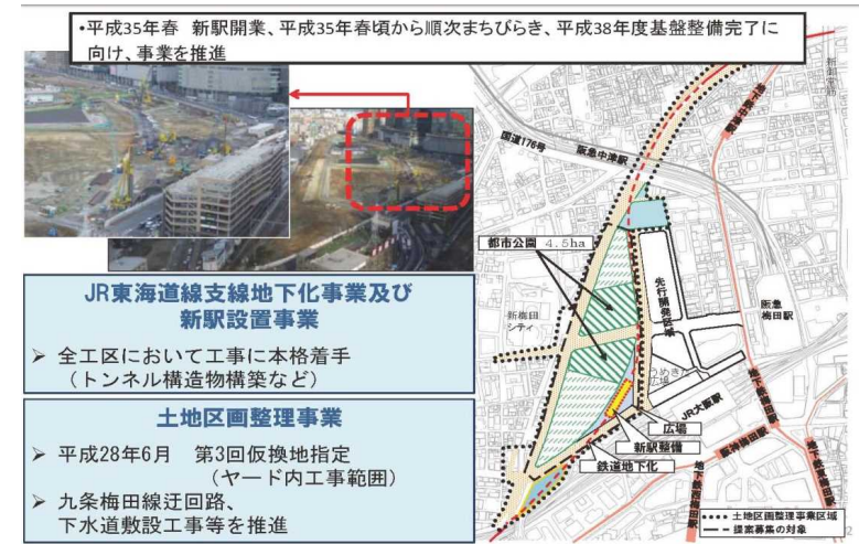
うめきた2期区域の基盤整備の進捗状況（提供：大阪府）
